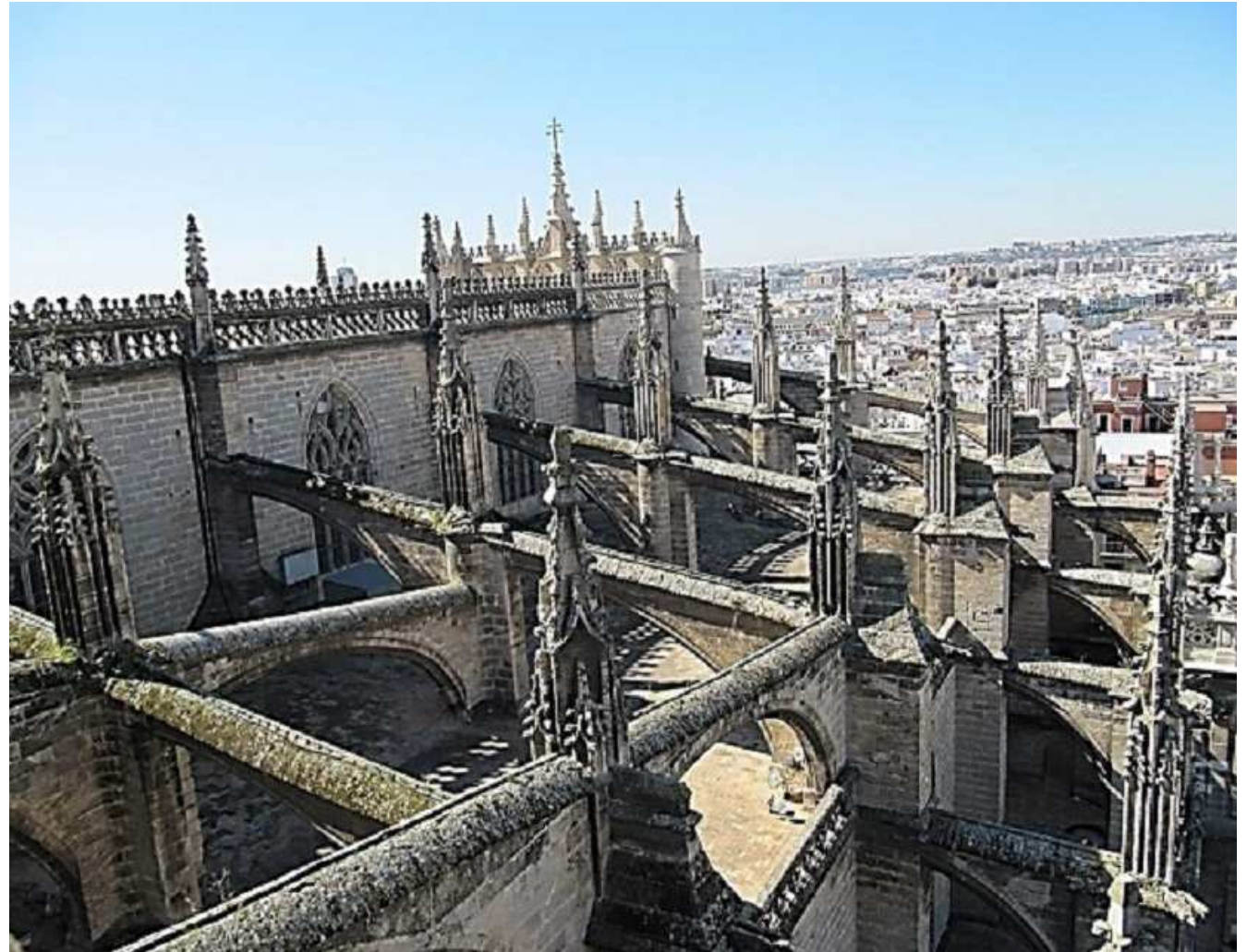
Cubiertas de la Catedral de Sevilla
