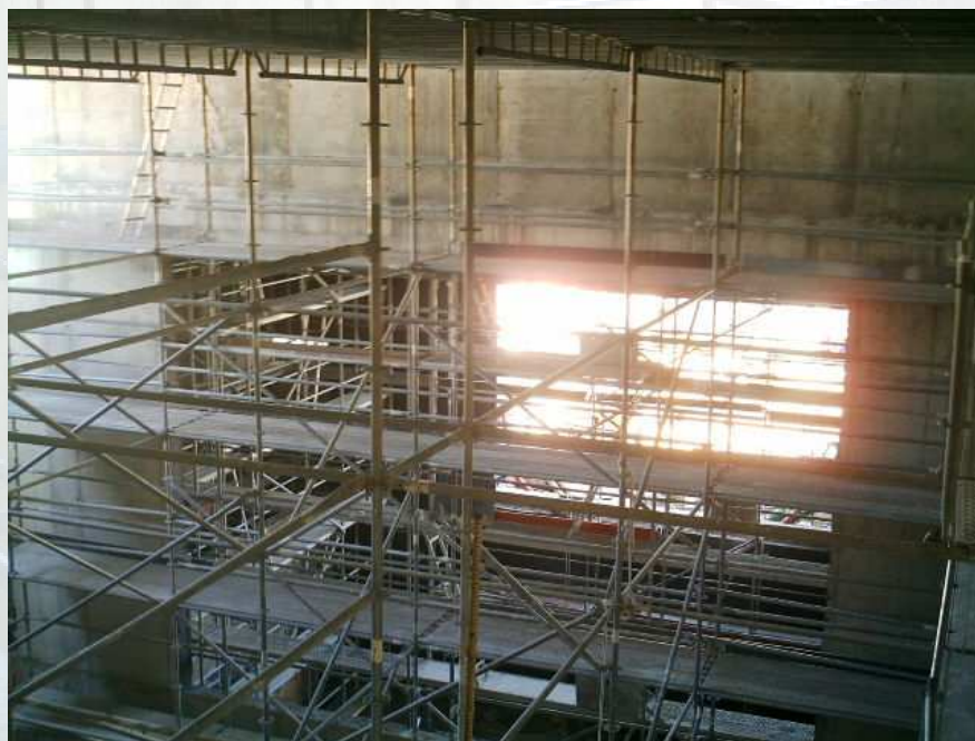
Nave de la Celulosa en Huelva
