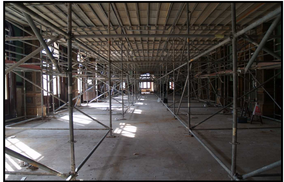
Plataforma suspendida para la limpieza de las bóvedas del campanario de la Giralda de Sevilla.
