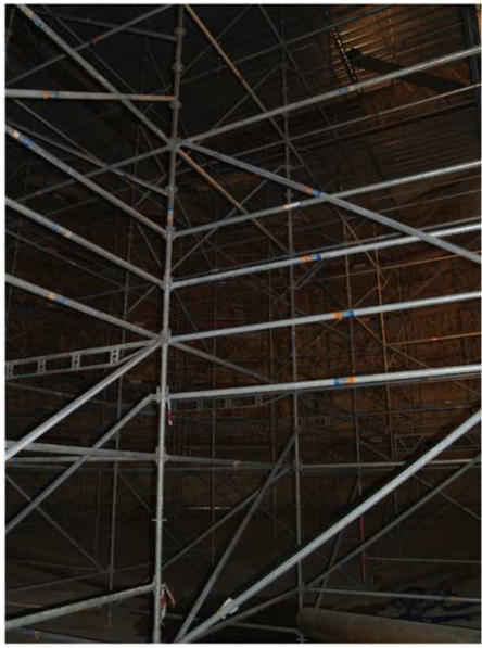
Plataforma para limpieza y mantenimiento de un digestor en la depuradora de El Copero.
