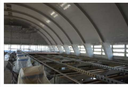
Rehabilitación del techo de una cubierta semicilíndrica en la Sala de Filtros de la depuradora de Villa Azul (Córdoba)
