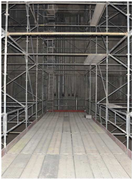
Plataforma para el acabado de dos digestores en la depuradora de Gelves.
