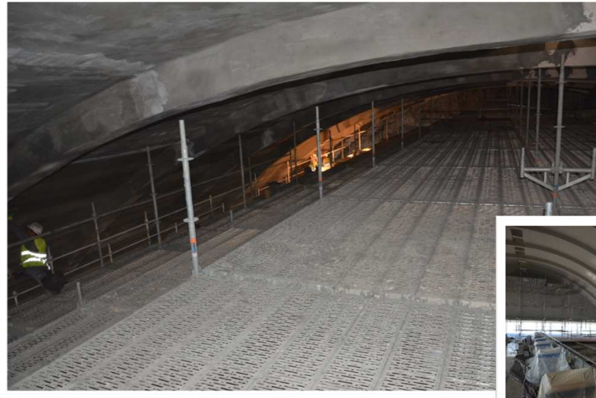
Rehabilitación del techo de una cubierta semicilíndrica en la Sala de Filtros de la depuradora de Villa Azul (Córdoba)
