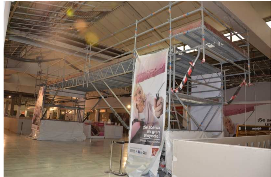
Remodelación del techo Centro Comercial Los Arcos
