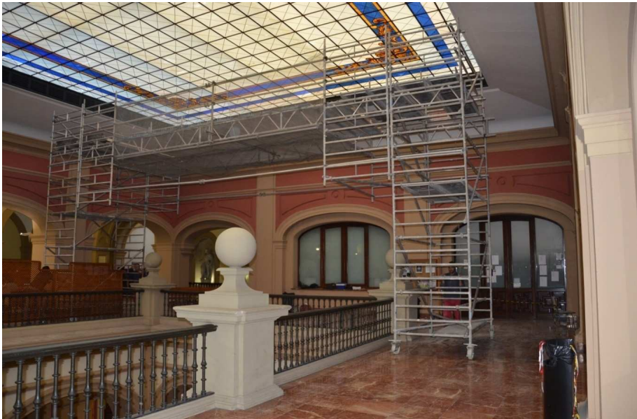
Limpieza de vidriera en el Rectorado de Sevilla.
