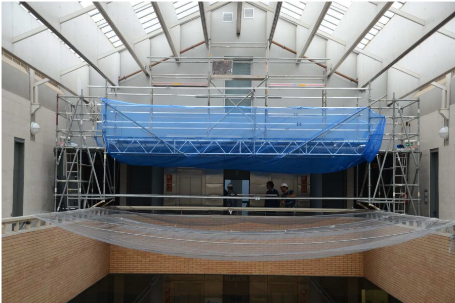
Limpieza de techo de cristal Edificio Realía
