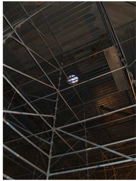
Plataforma para limpieza y mantenimiento de un digestor en la depuradora de El Copero.
