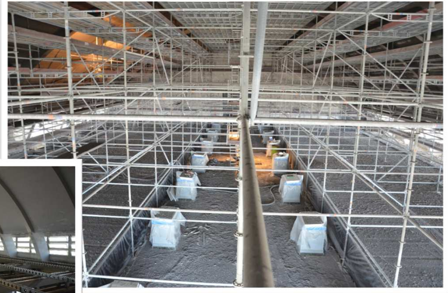
Rehabilitación del techo de una cubierta semicilíndrica en la Sala de Filtros de la depuradora de Villa Azul (Córdoba)
