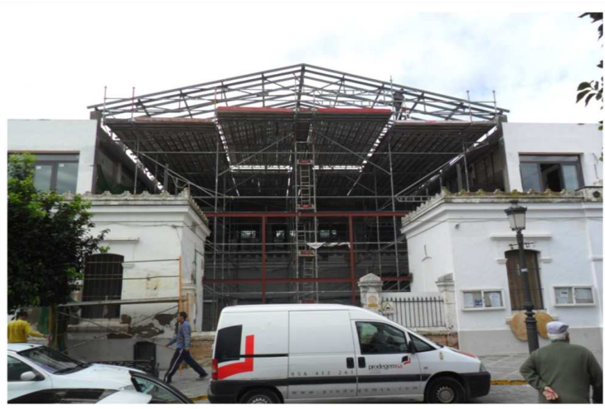
Rehabilitación de la cubierta a dos aguas del Mercado de Abastos de Medina Sidonia (Cádiz) .
