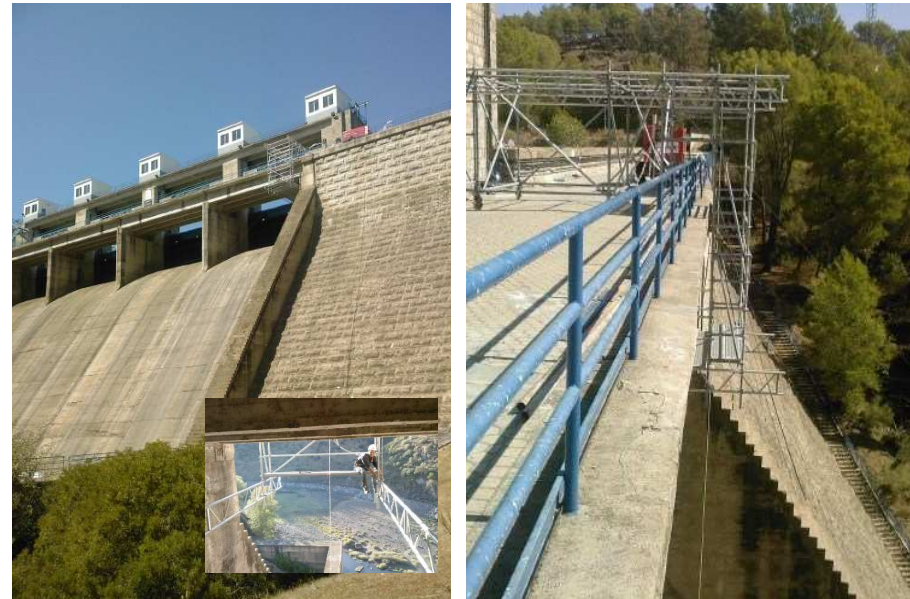
Reparación de los bajos del tablero Presa de la Minilla.
