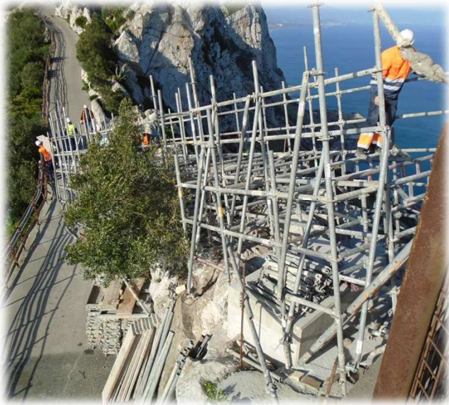
Rampa para subida de grúa de 5.000Kg. al mirador de Mount Misery (Gibraltar)
