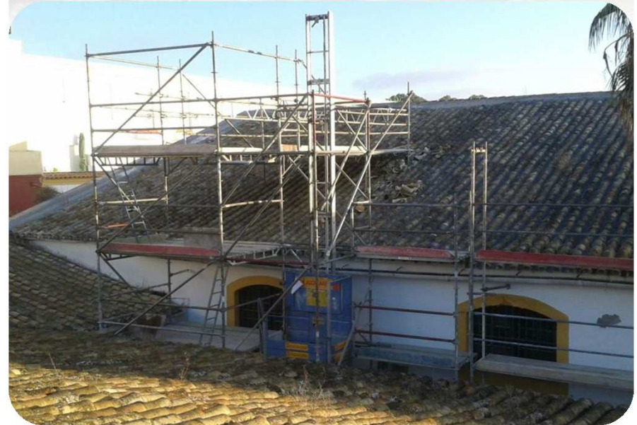
Arreglo de cubiertas en una bodega-Puerto Santa. María
