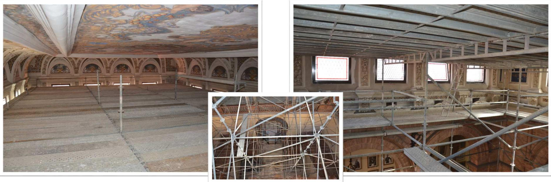
Restauración tramo cornisa superior y techo de la puerta de Castilla y León de la Plaza de España de Sevilla .
