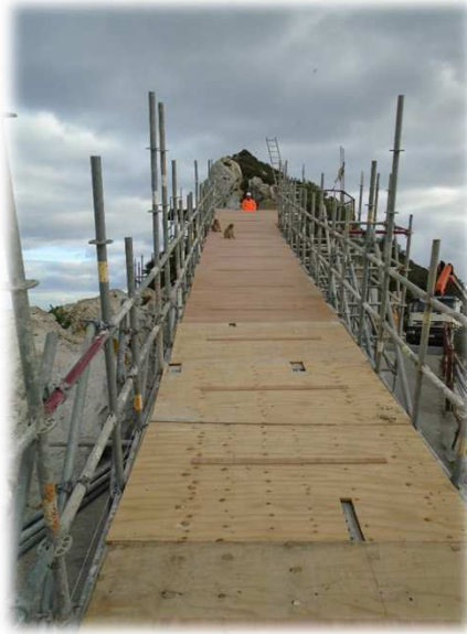
Rampa para subida de grúa de 5.000Kg. al mirador de Mount Misery (Gibraltar)
