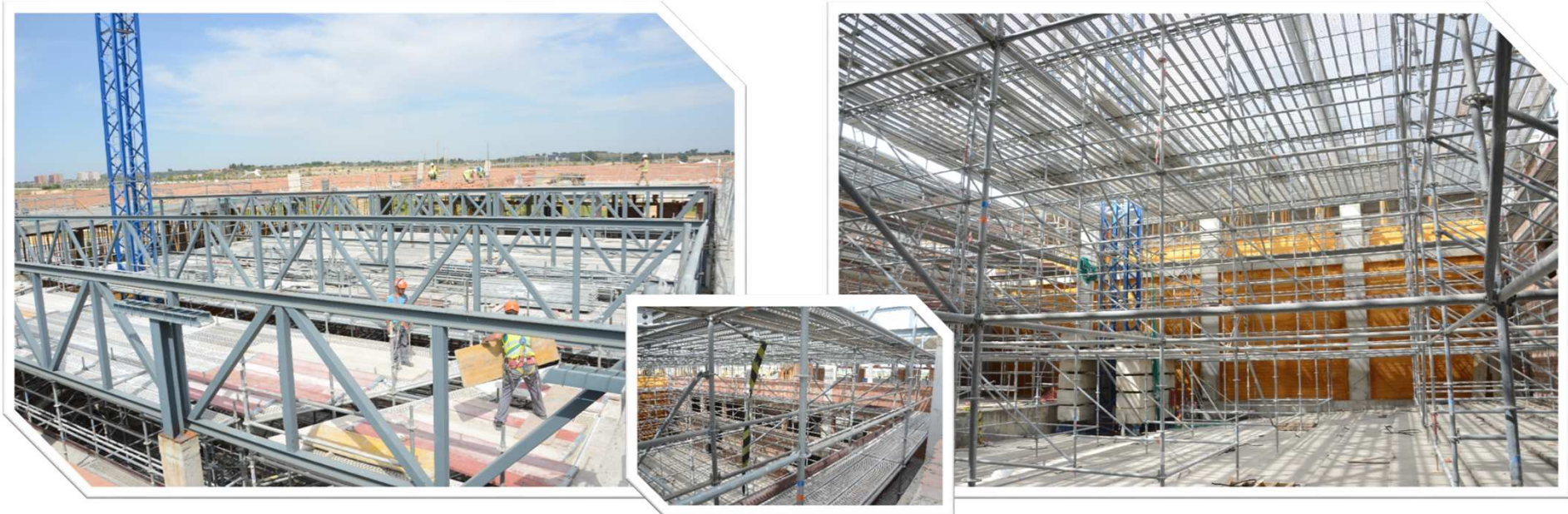
Construcción Centro Cultural Montequinto – Dos Hermanas (Sevilla)
