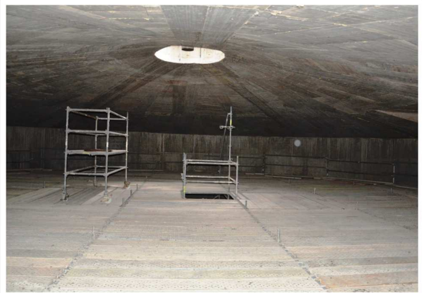
Plataforma para limpieza y mantenimiento de un digestor en la depuradora de El Copero.
